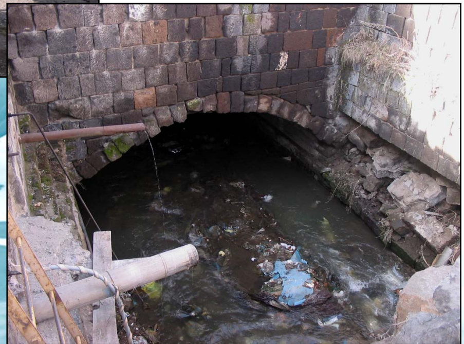
Ստորգետնյա վթարային սելեվատար Շահունյան փողոցում (լուսանկարը Ռ.Գասպարյանի)
